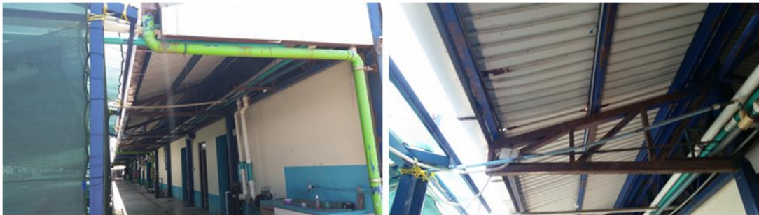
Figura 1: Sección sur del techo del corredor del edificio principal a remodelar y mejorar.
