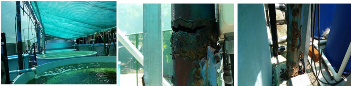
Fig. 3: Condiciones de área anexa actual
